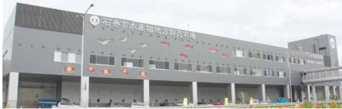
石巻魚市場（平成27年9月完成）
